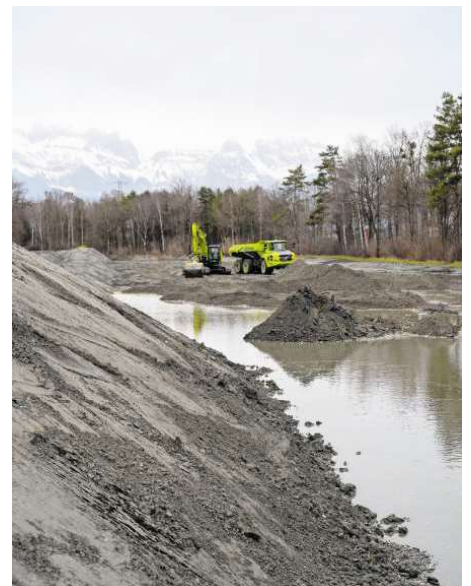
Hier wird der revitalisierte Werdenberger Binnenkanal bereits ab Mitte 2024 durchflossen.
