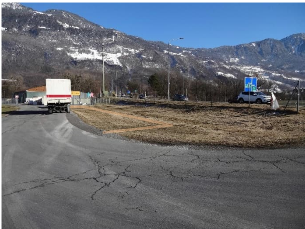
Abb. 44: Einfahrt Betonwerk, späterer Parkplatz
