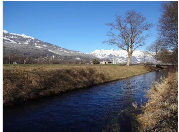
Abb. 43: WBK Bestand, wird verfüllt
