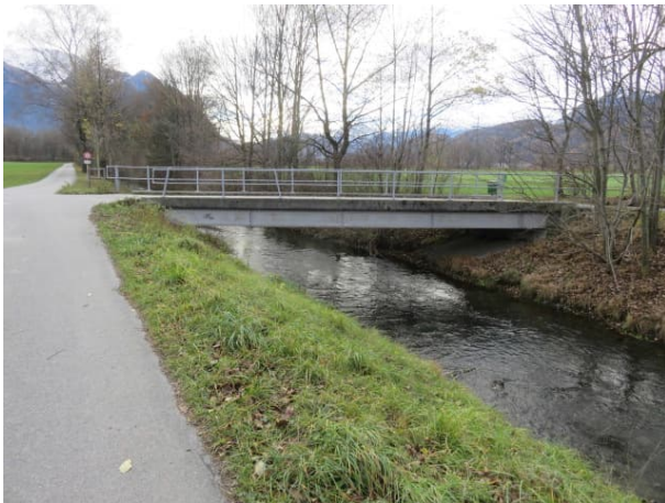
Abb. 42: Rückbau Brücke / Strasse, zu verfüllender WBK
