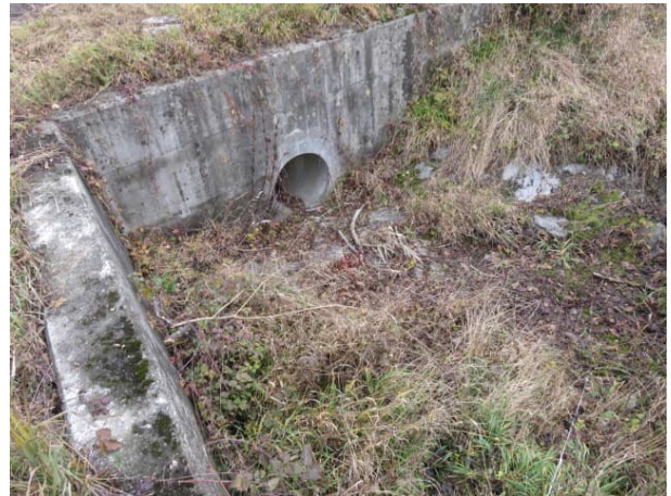
Abb. 37: Durchlass Gewässer unter Autobahn Profil 20, trocken
